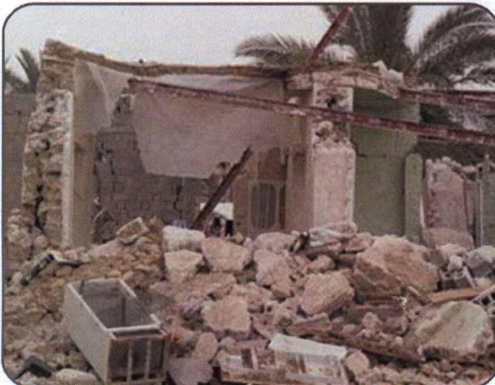
تخریب کامل ساختمانهای مسکونی تیر آهنی با دیوارهای ساخته شده با مصالح رودخانه‌ای و عدم رعایت استاندارد ساخت و ساز، شهر شنبه
