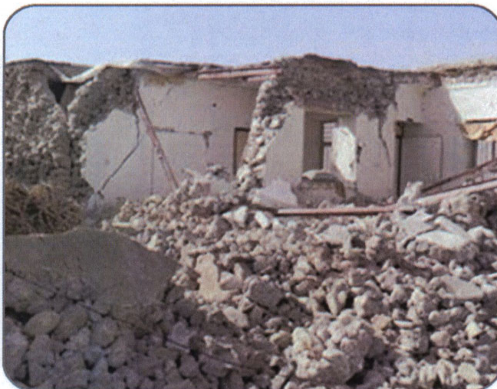
تخریب کامل ساختمانهای مسکونی تیر آهنی با دیوارهای ساخته شده با مصالح رودخانه‌ای و عدم رعایت استاندارد ساخت و ساز، شهر شنبه
