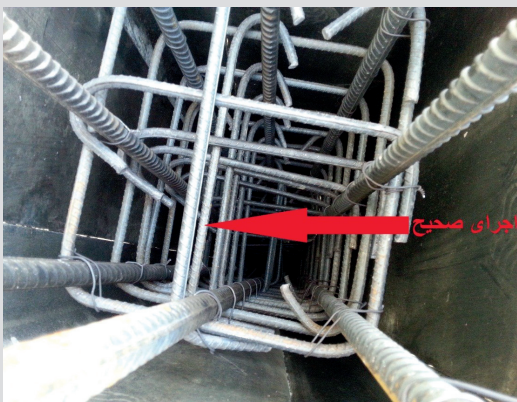
تصویر شماره ۴) روش صحیح اجرای سنجاق
