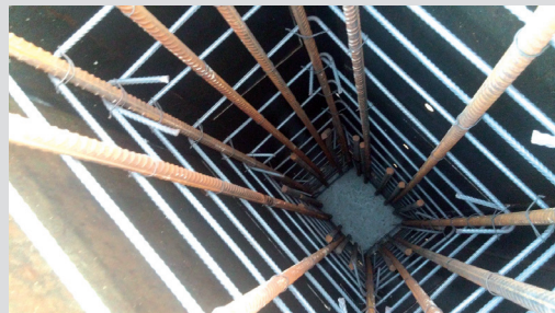
تصویر شماره سه : عدم اجرای سنجاق (ستون قالب بندی شده وآماده بتن ریزی است.)
