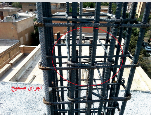
تصویر شماره ۵) روش صحیح اجرای سنجاق
