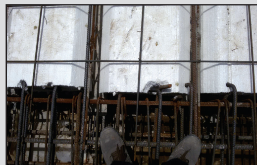
تصویر شماره یک: چسبیدن میلگردها به یونولیت در سقف تیرچه یونولیت
