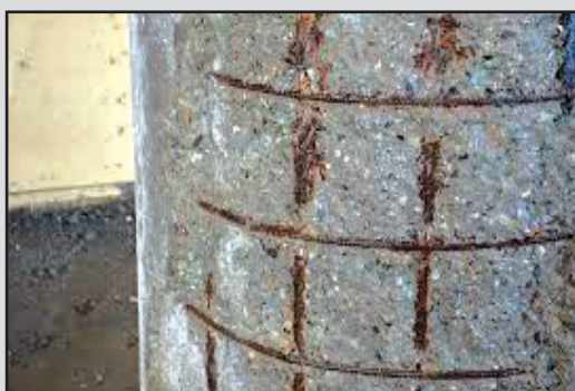
تصویر شماره (۱۰) عدم رعایت کاوربتنی میلگردها در در یک پوسته بتنی و آغاز فرایند خوردگی
