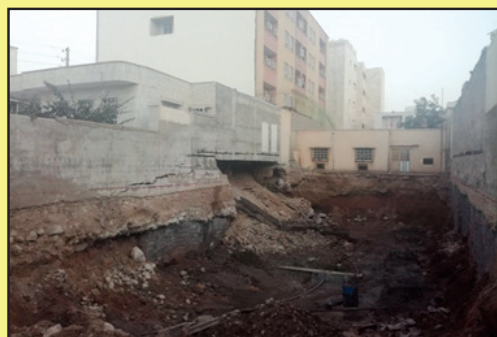
شکل ۲: وضعیت گود یک روز پیش از تخریب سازه مجاور
