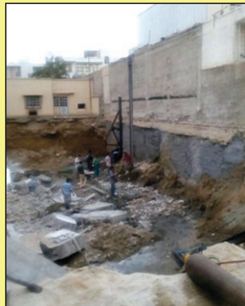
شکل ۴: شروع اجرای سازه نگهبان ضلع غربی در روز پس از حادثه
